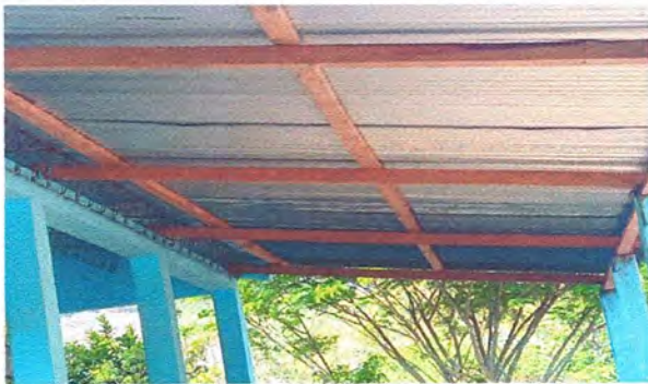
Foto 3 sustitucion estructura de madera por el estructura de metal.
