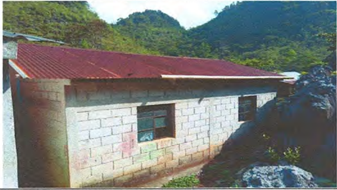
Foto 1: cambio de techos de la EORM para mejorar las condiciones del establecimiento.
