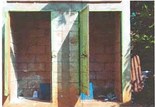
Foto 4: reparacion de baños en toda su estructura.
