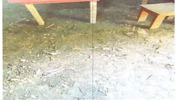
Foto 6: sustitucion de piso.
